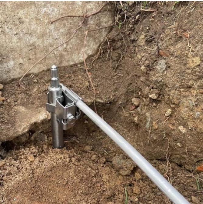
Fachgerechte Installation eines Tiefenerder NIRO (V4A)
