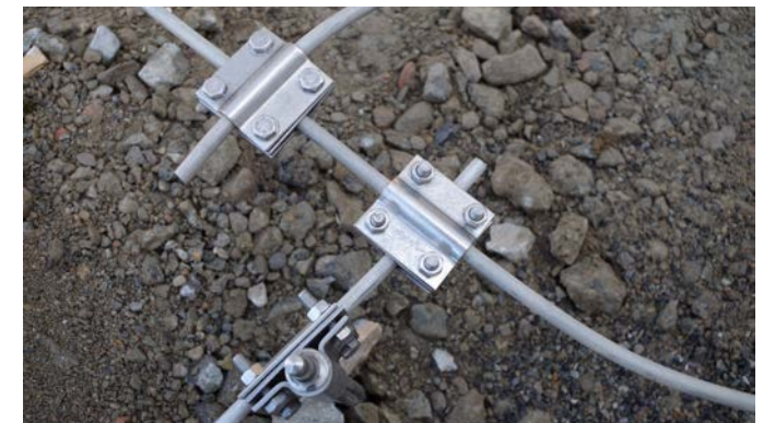
4b) Detailbilder von Verbindungen im Erdreich – Beispiel Anschluss Tiefenerder und Verbindungsleitung
